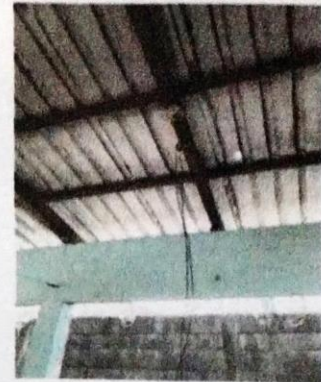
Foto 2: se retira toda la instalacion electrica antigua dañada
