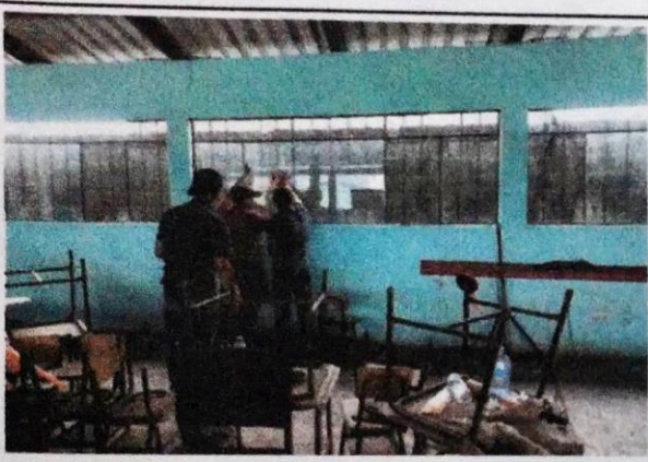
Foto 3: se empieza a colocar el vidrio nuevo en las ventanas
