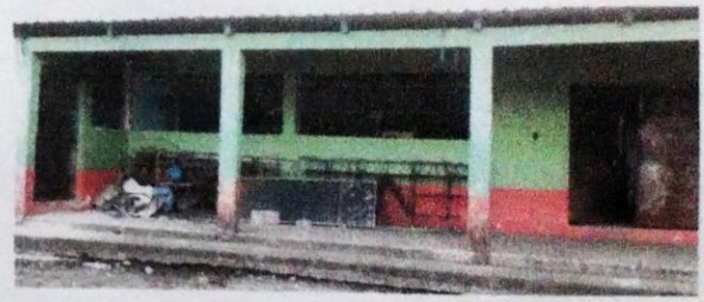
Foto 4: se retiran las puertas para pintado y colocacion de chapas nuevas
